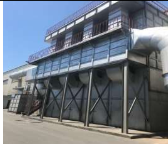
图 5 急冷装置+活性炭喷射+布袋除尘器
